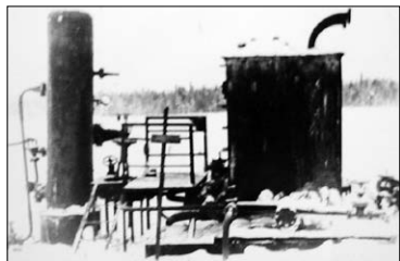
Передвижная замерная станция.
